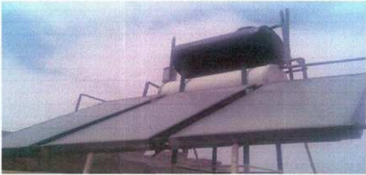
الشكل (3) المجمع الشمسي المسطح المدروس.
