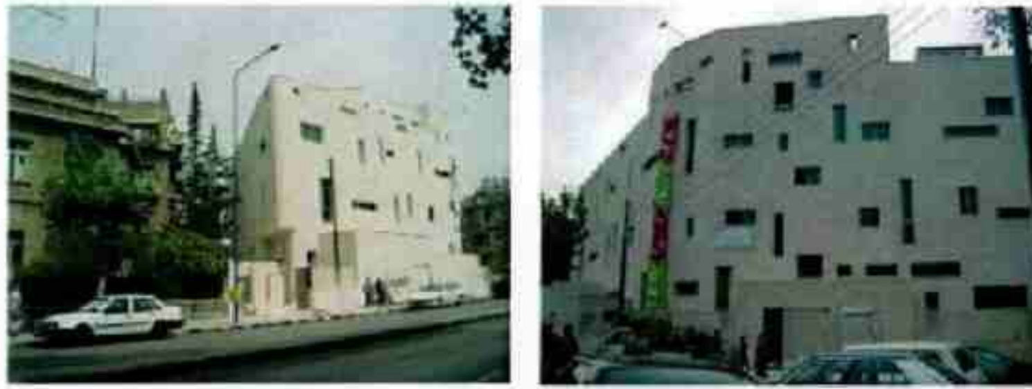
الشكل 33-34 مبنى السفارة اليابانية في شارع الجلاء/ المعمار ايطالي
