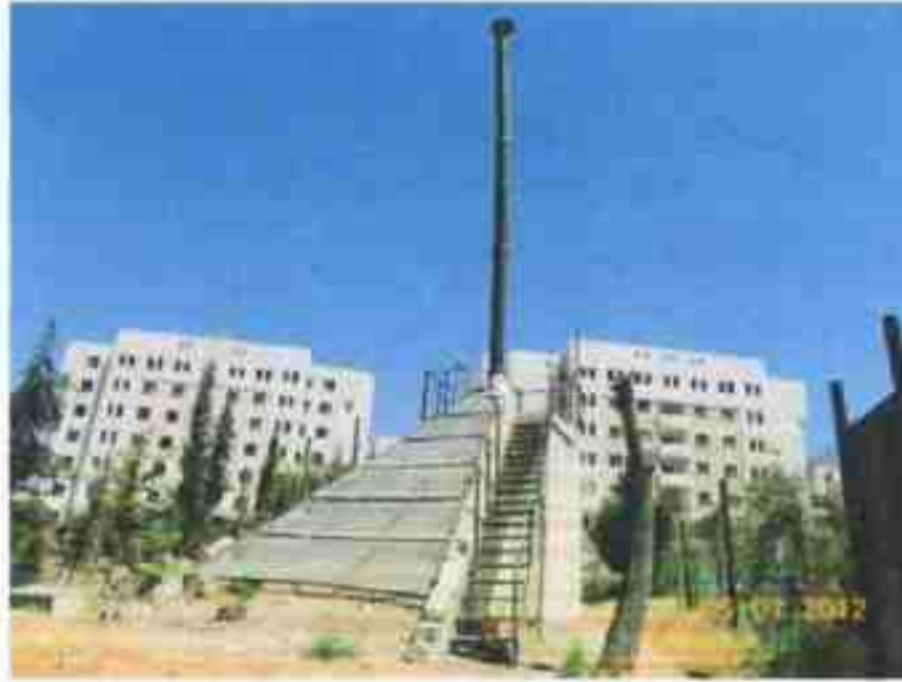
الشكل (6): الشكل النهائي للمنصة الإختبارية لمحطة المدخنة الشمسية المائية
