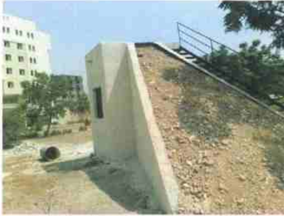
الشكل (4): اللاقط الشمسي المائل بعد تجهيز سطحه العاكس (التربة الجبلية)
